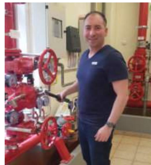
Sami Kokasch mit Drehmomentschlüssel in der Hand, neben einer Ventilstation einer Sprühflutanlage, welche pneumatisch oder elektrisch ausgelöst werden kann. Durch offene Düsen kann bei dieser Station Löschwasser im gesamten Schutzbereich verteilt werden. Bei Bedarf kann dem Löschwasser ein filmbildendes Schaummittel zugemischt werden.
