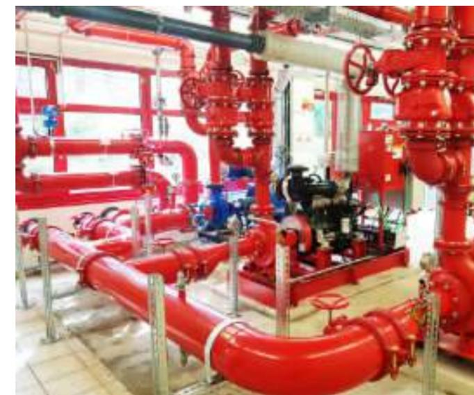
Pumpenzentrale zur Wasserversorgung: Die Elektro- und Diesellaggregate pumpen bei einer Auslösung Wasser in die Alarmventilstationen, durch einen Zumischer kann auch Schaummittel beigemischt werden. Das Diesellagregat soll als Redundanz auch bei Stromausfall die zuverlässige Funktion der Löschanlage gewährleisten. Der Mindestinhalt des Kraftstoffbehälters wird elektrisch überwacht, bei Unterschreitung erfolgt rechtzeitig eine Störmeldung.
