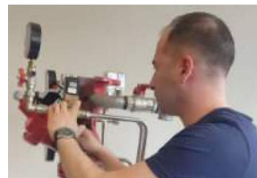
Modell einer Sprühflutventilisation; die linke Hand zeigt auf die gelbe manuelle Handauslösung für den Ernstfall.
